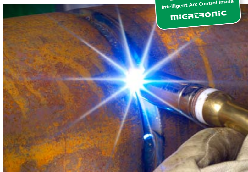
Svislé provařování kořenové vrstvy prováděné shora za použití funkce IAC™ při pokládání potrubí dálkového vytápění. Ve srovnání s tradičním svařováním prováděným ve směru zdola nahoru se dosahuje podstatného zvýšení rychlosti.
